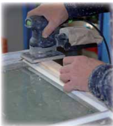
Eventuell träkomplettering, spackling och slipning.
