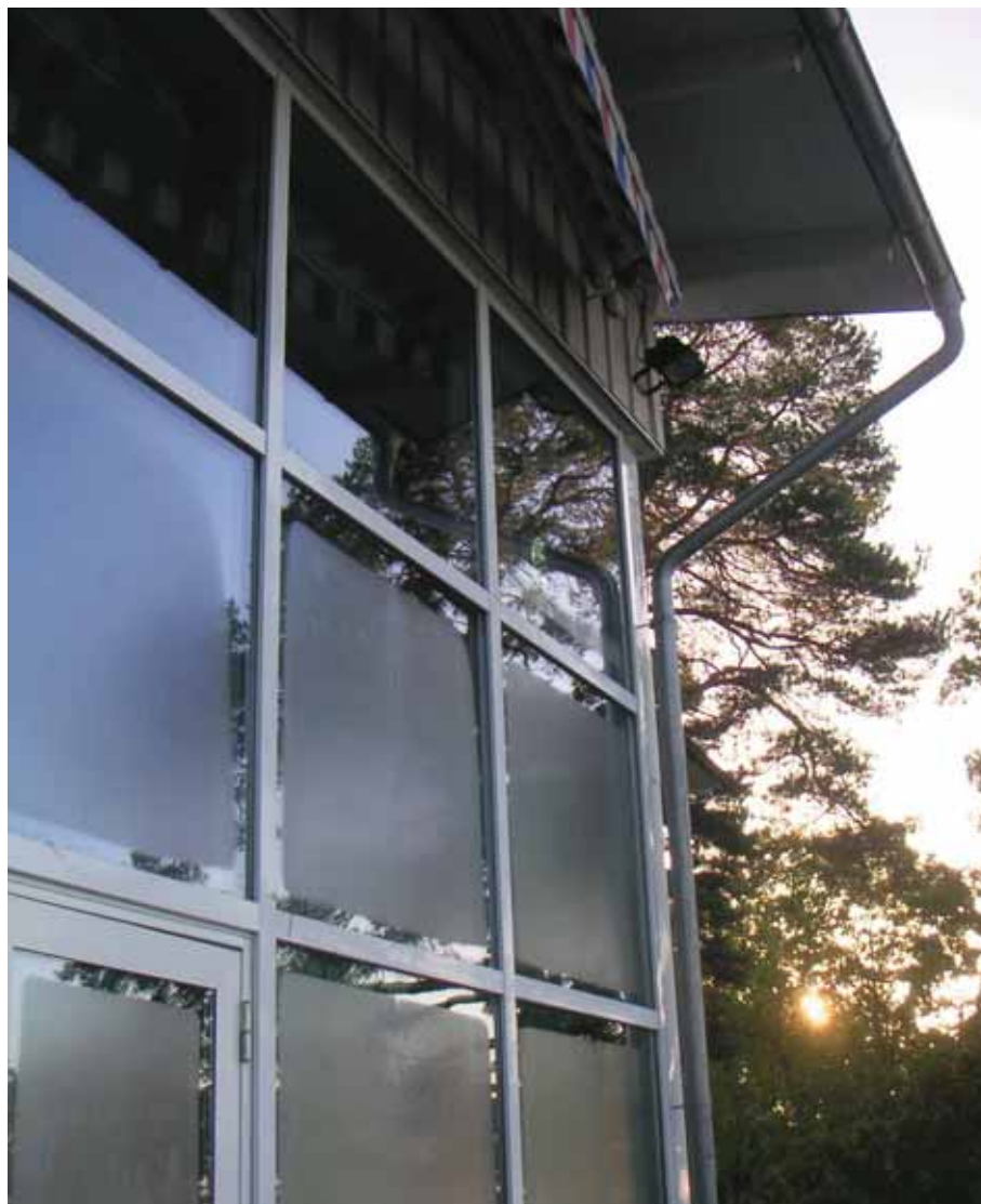
Bild 59. Ingen utvändigt kondens under takfot eller i närheten av isolerrutans kanter pga större värme-läckage. Isolerrutan har U_g ca 0,8 \text{ W/m}^2\text{K} .
