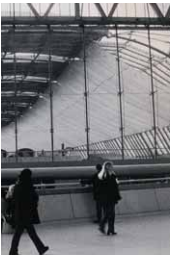
Bild 71. Waterloo station i London. Det undre härdade glaset i taket spontangranulerade och man har tvingats hänga tältliknande skyviken under för att glas inte ska trilla ned på folk på stationen.
